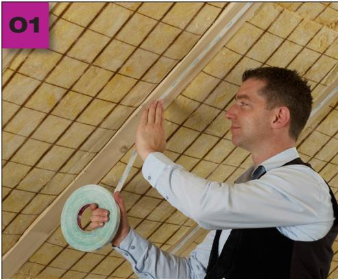
**Utilice la tira adhesiva de doble cara Twinet en el montaje de Majpell en estructuras de madera**
