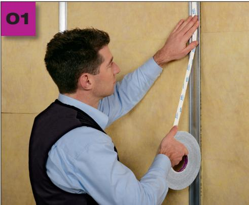
Utilice la tira adhesiva de doble cara Twinet en el montaje de Majpell en estructuras metálicas
